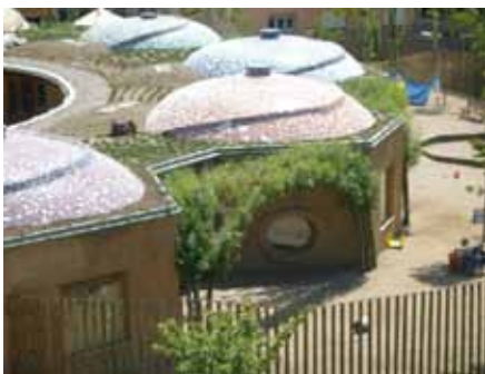
DETALL DE LES CÚPULES NÚVIES I PÈRGOLA VEGETAL DE L'ESCOLA BRESSOL
