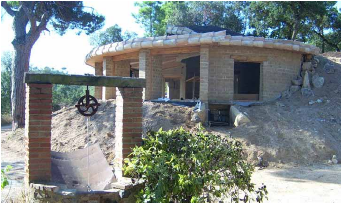
FAÇANA SUD-EST DE LA MASOVERIA BIOCONSTRUCTIVA EN LA FASE D'ACABATS. DETALL DEL POU EXISTENT (VEGEU LA FITXA A LA PÀGINA SEGÜENT)
