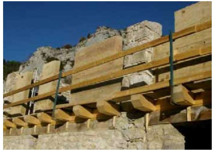
MURS ESTRUCTURALS DE TERRA COMPACTADA DE LA FAÇANA SUD AL REFUGI D'ARDERICÓ, EL CATLLARÀS
