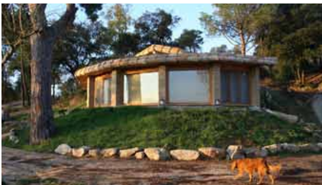
FAÇANA SUD SEMISOTERRADA, LES FINESTRES ES TROBEN A 0,90 M DEL PAVIMENT INTERIOR
