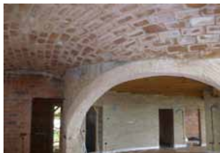
DETALL DE RECOLZAMENT DE LA VOLTA CATALANA AMB ARC ESTRUCTURAL, D'UNA CASA A SANTA EULÀLIA DE RONÇANA
